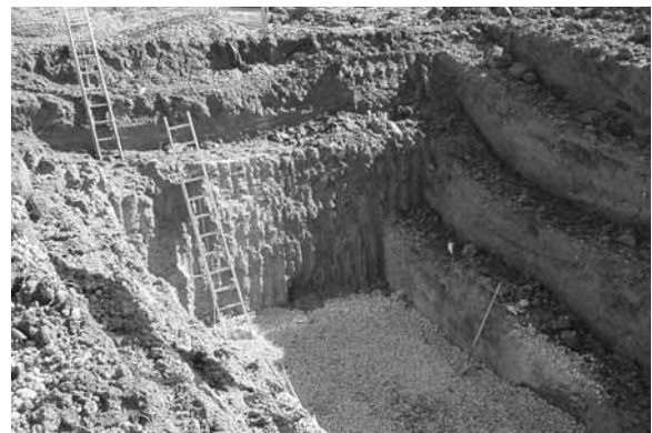
Pozo para la máquina perforadora con barrena
