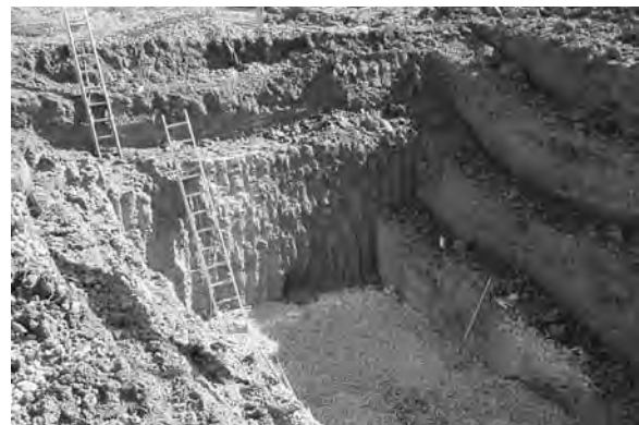
Poço de perfuração da verruma
