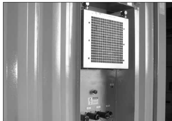
SN FA21965F Oil Cooler Fan Shown
