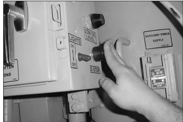
Se muestra la unidad de bombeo 5000
